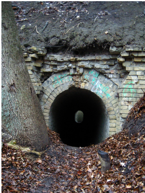
Рис.3.9. Дренажна система починається від верхнього тунелю
